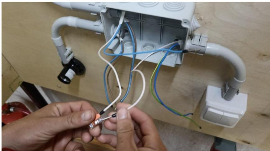
Соединяем (синий) фазный провод с выключателя с клемным зажимом.
