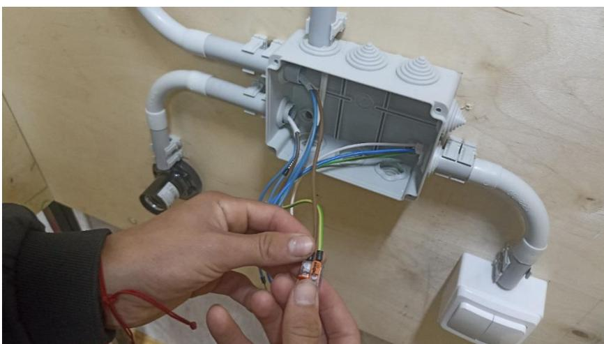
Соединяем оставшиеся (синие) провода с помощью клемного зажима.
