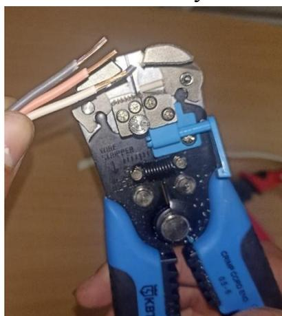
Произвести оконцевание каждой жилы кабеля с помощью НШВИ (наконечник штыревой втулочный изолированный), и пресс-клещей.
