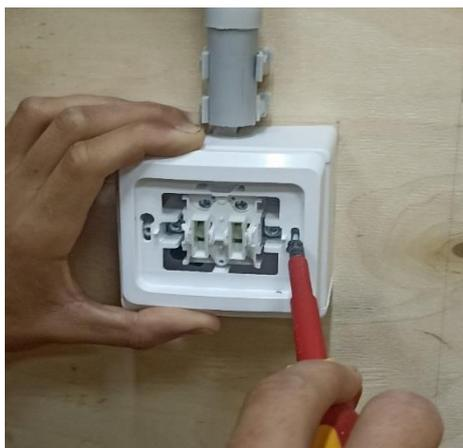
Вставляем в корпус выключателя правую и левую клавиши
