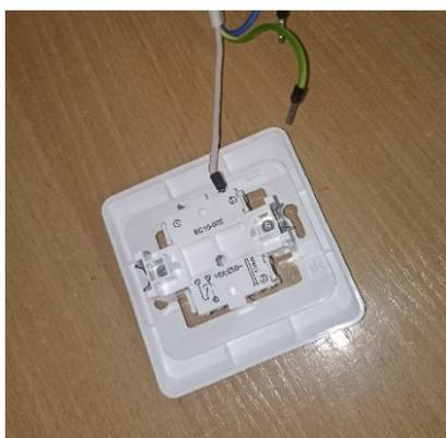
Производим соединение синего провода с контактом «1» выключателя.
