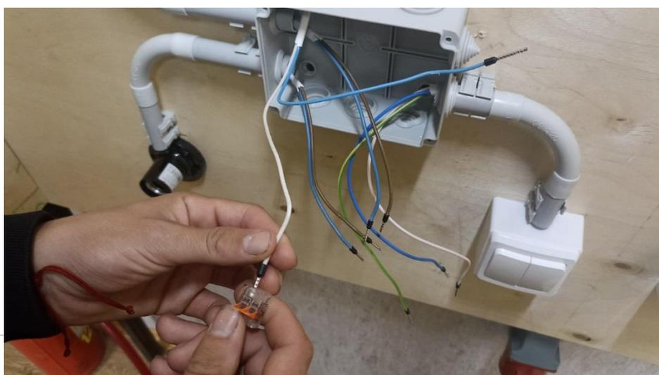
Соединяем фазный (белый) провод с выключателя с питающим (белым) фазным проводом.
