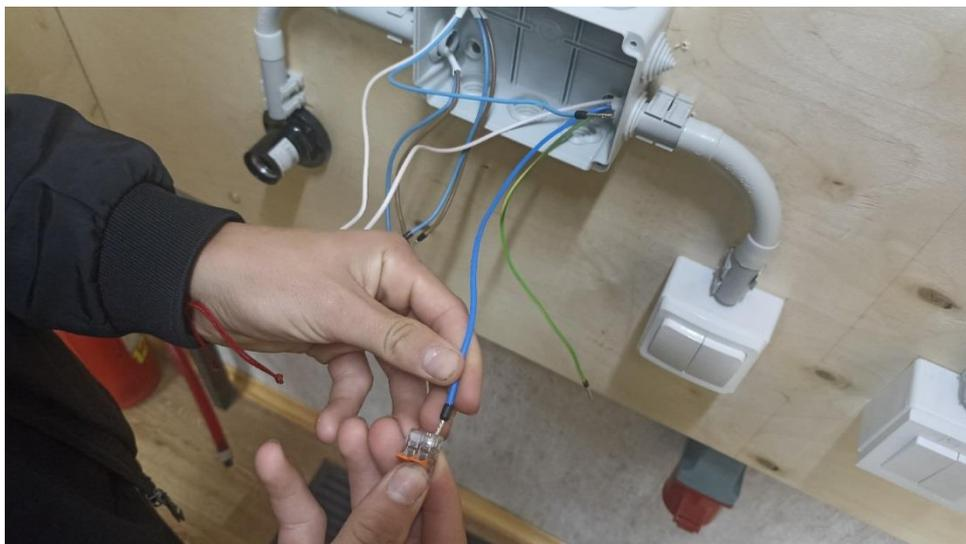
Соединяем (коричневый) фазный провод со светильника с синим фазным проводом с выключателя с помощью клемного зажима.
